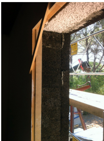
Aïllament amb suro
